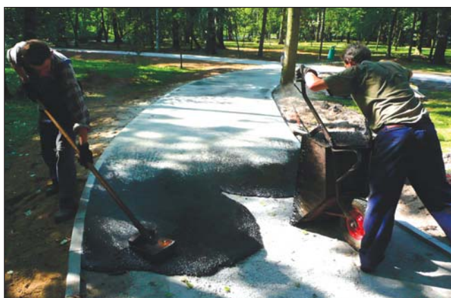
W Parku Solvay trwa remont alejek.
