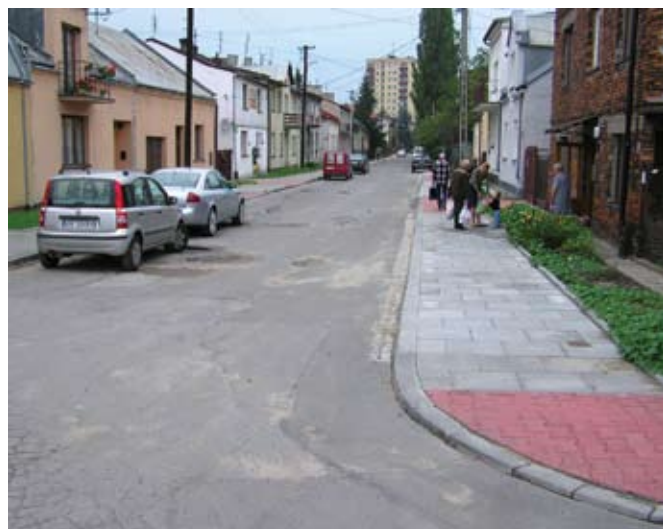
Chodniki po remoncie przy ul. Hoffmanowej pozwolom wszystkim poruszać się bezpieczniej
