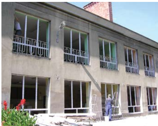
Wymiana okien w Przedszkolu Samorządowym Nr 95 przy ul. Żywieckiej odbyła się bardzo sprawnie
