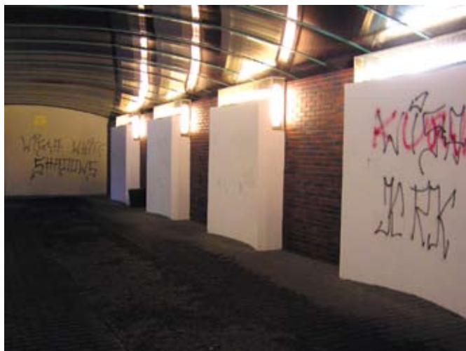
Tak wygląda przejście podziemne przy przystanku tramwajowym do Sanktuarium Bożego Miłosierdzia po majowym remoncie
