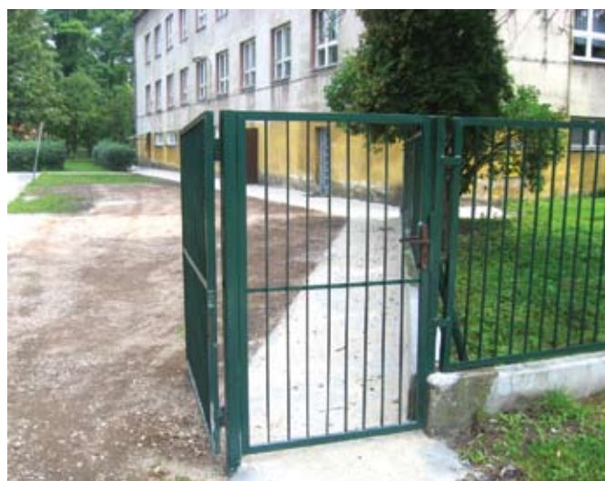
Chodnik przy szkole na ul. Niecałej po ukończeniu II etapu remontu
